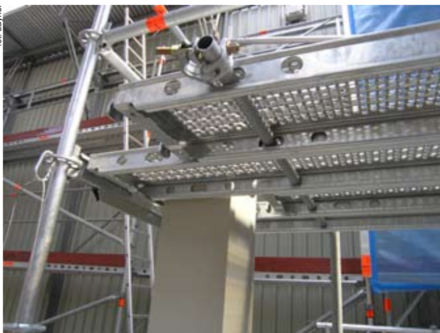
Fot. 4. Oryginalne rozwiązanie konstrukcji pomostów Layher
