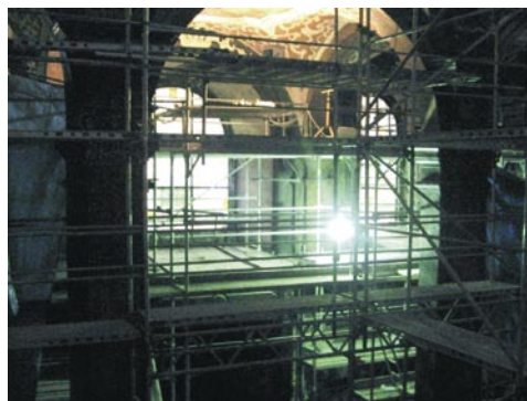
Widok na miejsce pracy konserwatorów (nawa boczna)
