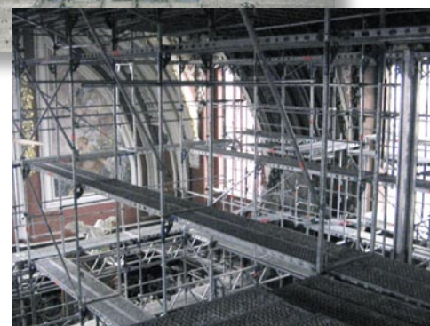
Platforma pod sklepieniem
