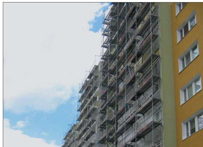
Osłonę boczną stanowią przyłączone są do ram pionowych poręcze stalowe
