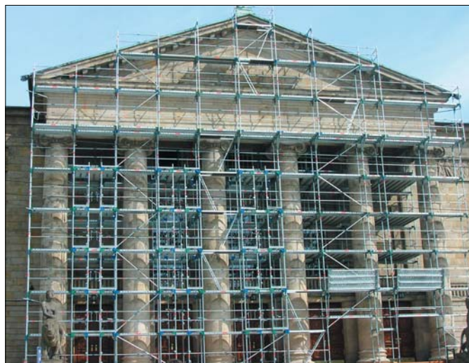
Dzięki możliwościom systemu rusztowań ramowych Layher Blitz również tak skomplikowana konstrukcja nie wymagała użycia rusztowania modułowego
