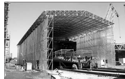
Fot. 4. Stocznia Gdańska Aluship Technology – dach kasetowy
