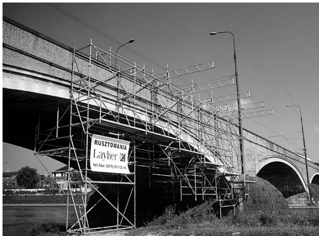
Fot. 1. Zastosowanie dźwigarów przy konstrukcji wiszącej mostu we Wrocławiu
