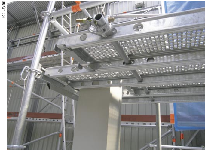
Fot. 2. Konsola wewnętrzna z pomostów T4
