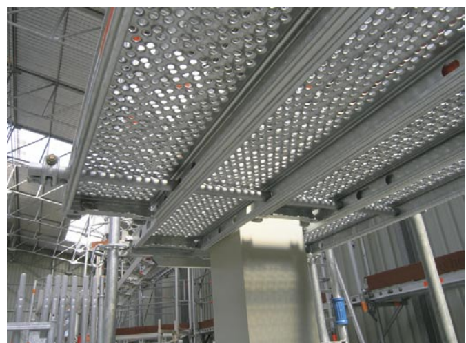
Fot. 3. Konsola niekonstrukcyjna AR
