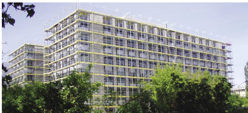
System Blitz – zarusztowanie fasady (budowa firmy Ramirent)
