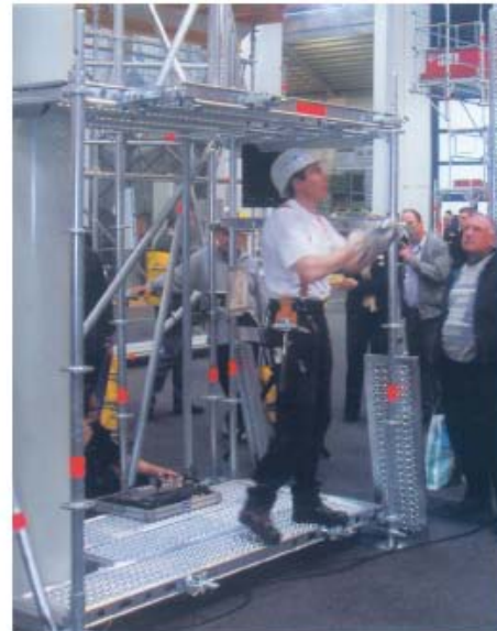
► Pomost stalowy T4, szer. 0,32 m
